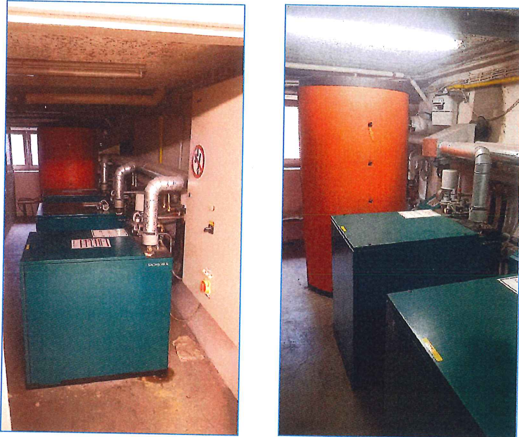
Abbildung 2: 3-fach-BHKW-Anlage im Bestand m. Pufferspeicher
