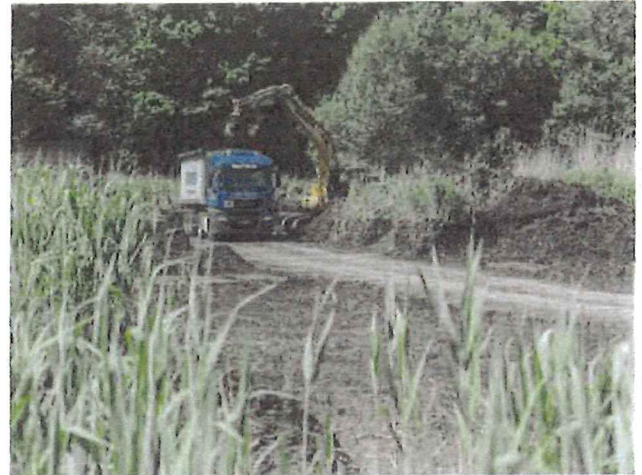
Bild 3: Nach acht bis zwölf Jahren ist ein Beet gefüllt. Die Klärschlammmerde wird ausgebaggt und abtransportiert. Aus einem im Beet verbleibenden Rest treibt das Schilf erneut aus.
