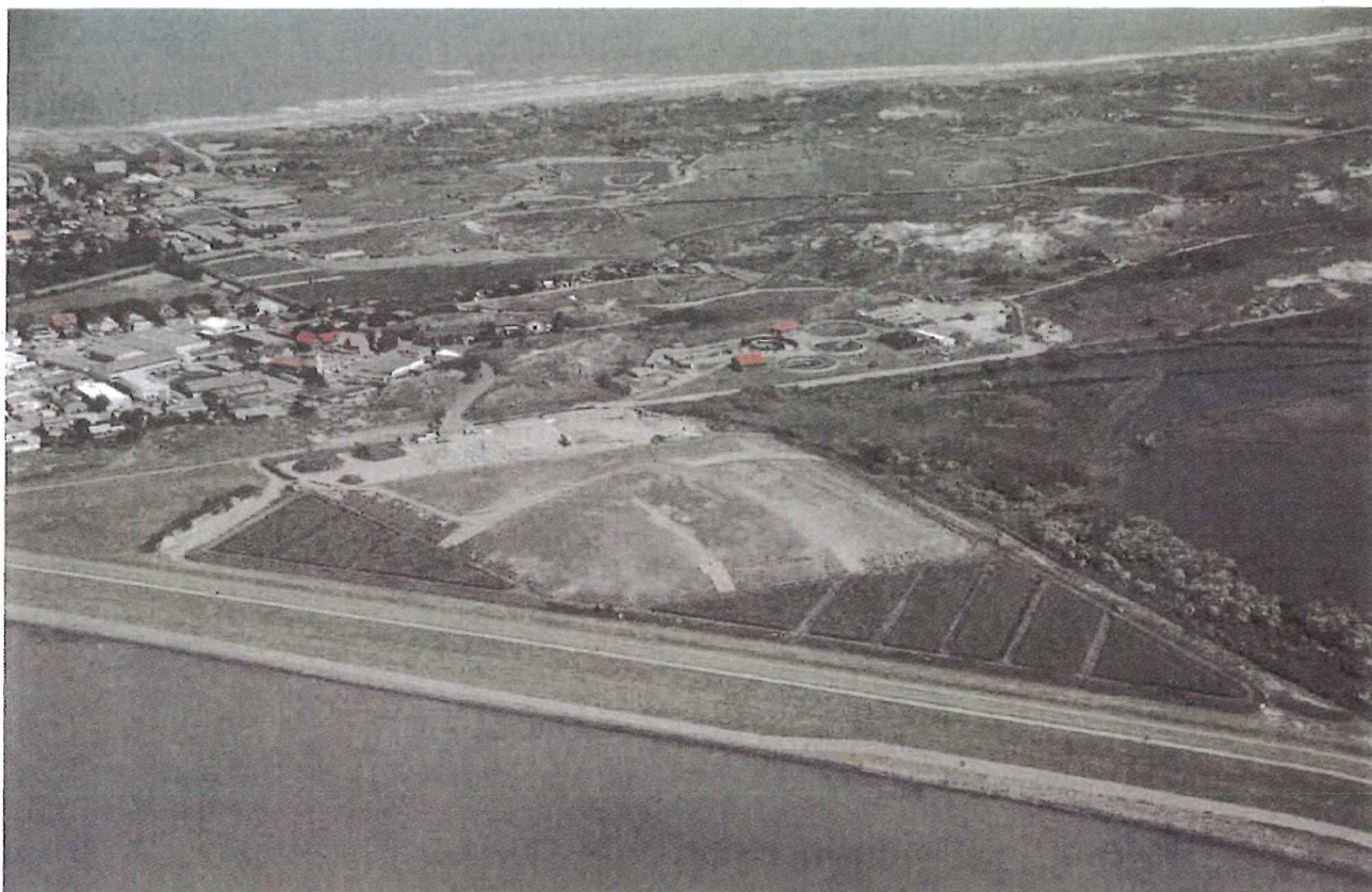
Bild 5: Die Klärschlammvererdungsanlage auf Norderney entwässert seit 1991 die saisonal stark schwankenden Klärschlammengen.
