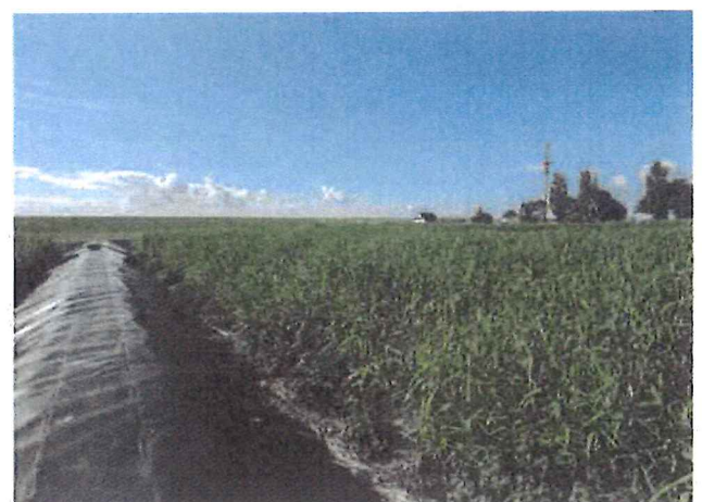
Bild 4: Der dichte Schilfbewuchs der Klärschlammvererdungsanlage Buisum nimmt problemlos auch saisonale Klärschlammspitzen auf und entwässert sie zuverlässig.
