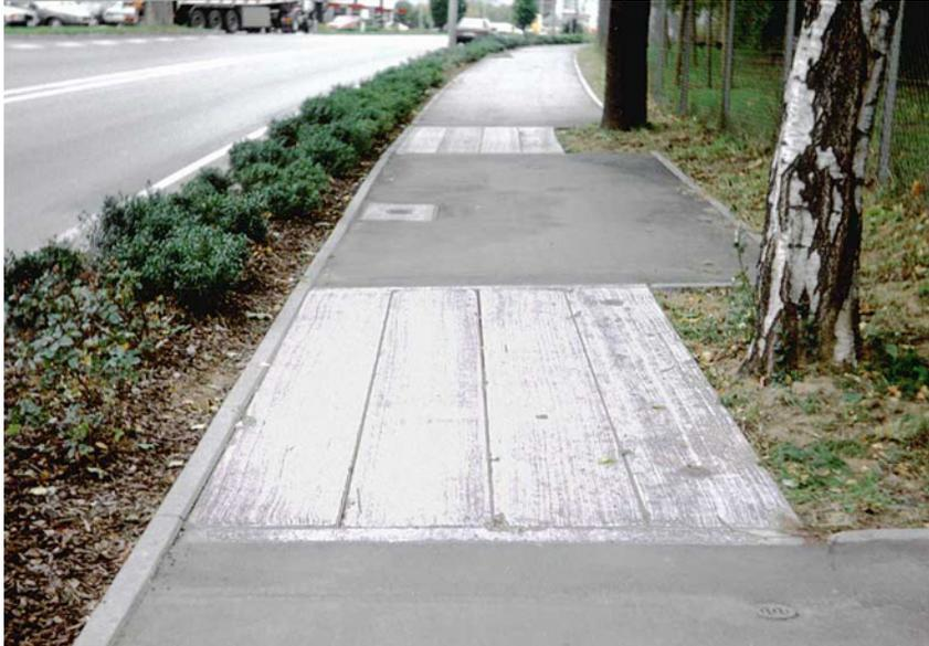
Wurzelschutzsystem gewährleistet einen unverdichteten Wurzelraum bei gleichzeitiger Überfahrbarkeit mit einem Raddruck von bis zu 10 t, Baukastensystem in vielen Größen lieferbar. Farben und Oberflächen wahlweise. Der Baum wird allseitig von den Betonelementen umfasst und geschützt.
