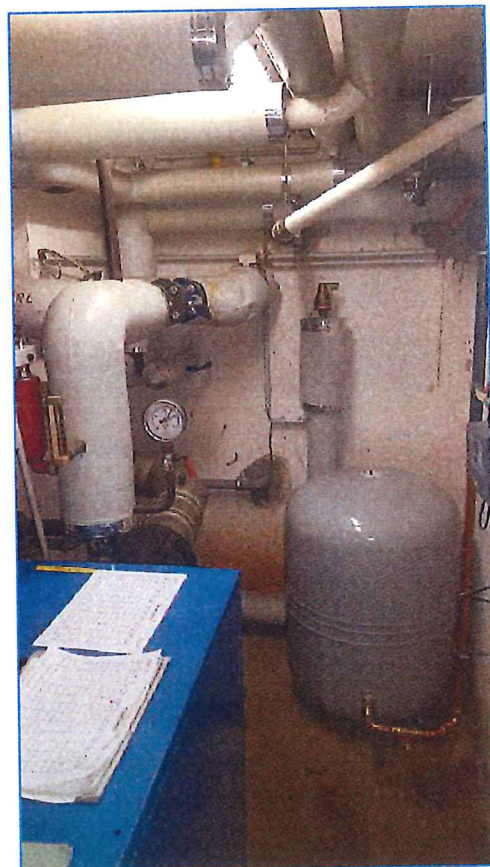
Abbildung 1: Gas-Gussgliederkessel im Bestand, 140 kW, Bj.: 1993 mit vorgebautem Schalldämpfer
