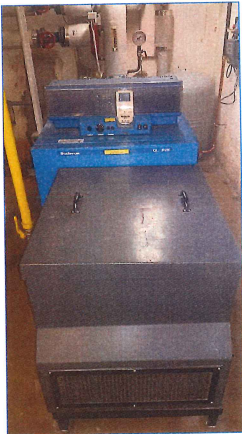
Abbildung 1: Gas-Gussgliederkessel im Bestand, 140 kW, Bj.: 1993 mit vorgebautem Schalldämpfer
